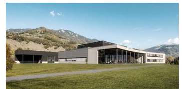
Die WITTENSTEIN AG in Grösch hat ihren Erweiterungsbau eingeweiht.
